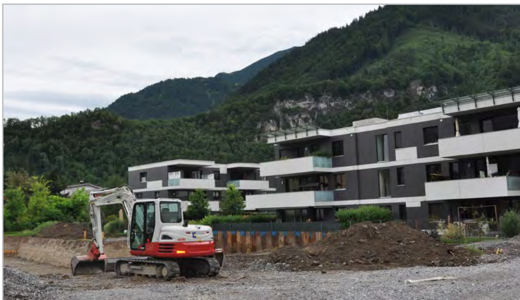
Eine neue Wohnanlage für Betreutes Wohnen und eine Kinderbetreuungseinrichtung entstehen Unterfeld.
