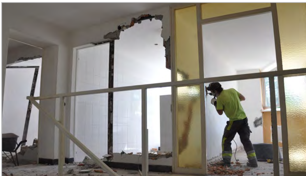
Abbrucharbeiten im Inneren der Volksschule Bludenz-Obdorf wurden schon durchgeführt.
