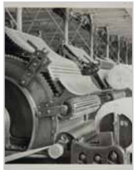
Beim Kardieren wird die Baumwollflocke in die Einzelfasern aufgelöst; Karden von 1886
