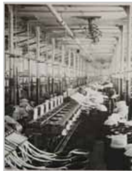
Blick in das Vorwerk: Flyer, Strecken und Karden, 1934/35
