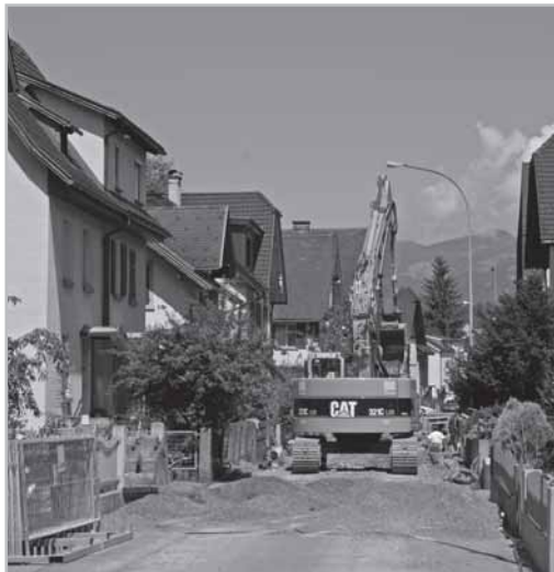
In der Gartenstraße sind die Bagger gerade aufgeföhren.
