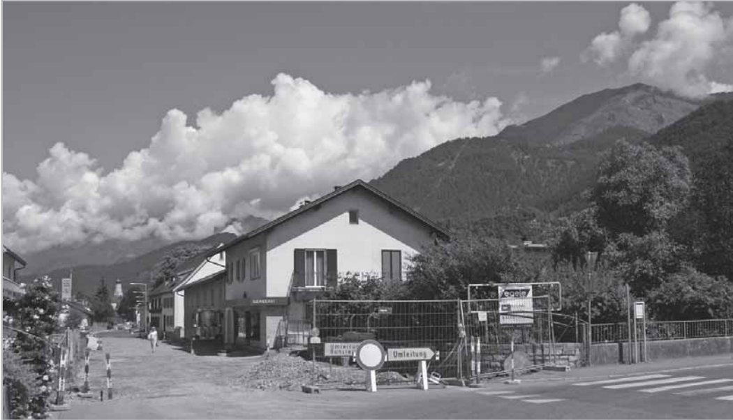
Die Baustelle St. Peterstraße wird in Kürze fertig sein.
