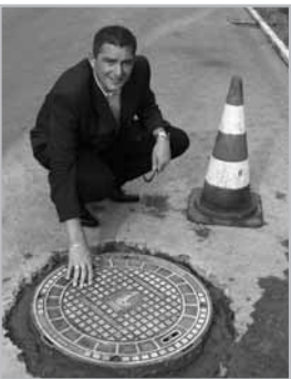
70 Kilometer Kanalnetz, 2.063 Kanalschächte, Gesamtinvestitionen 28 Millionen Euro
