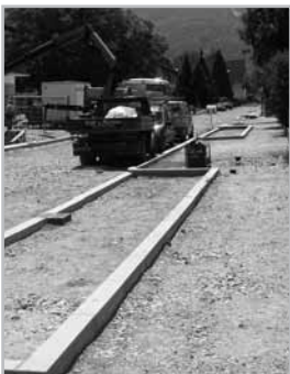
Bis Ende des Sommers wird die Baustelle Jellerstraße fertig sein
