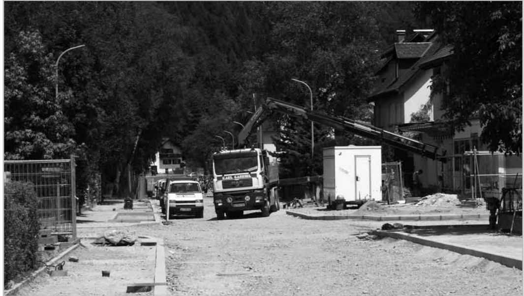
Eine der aufwändigsten Straßen- und Kanalbaustellen in Bludenz ist derzeit die Jellerstraße.
