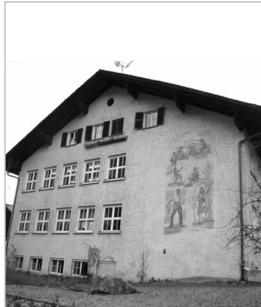
Im Sommer soll mit dem Bau einer Turnhalle und eines neuen Kindergartens begonnen werden.
